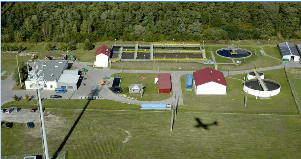
Oczyszczalnia ścieków w Kazimierzu Biskupim
